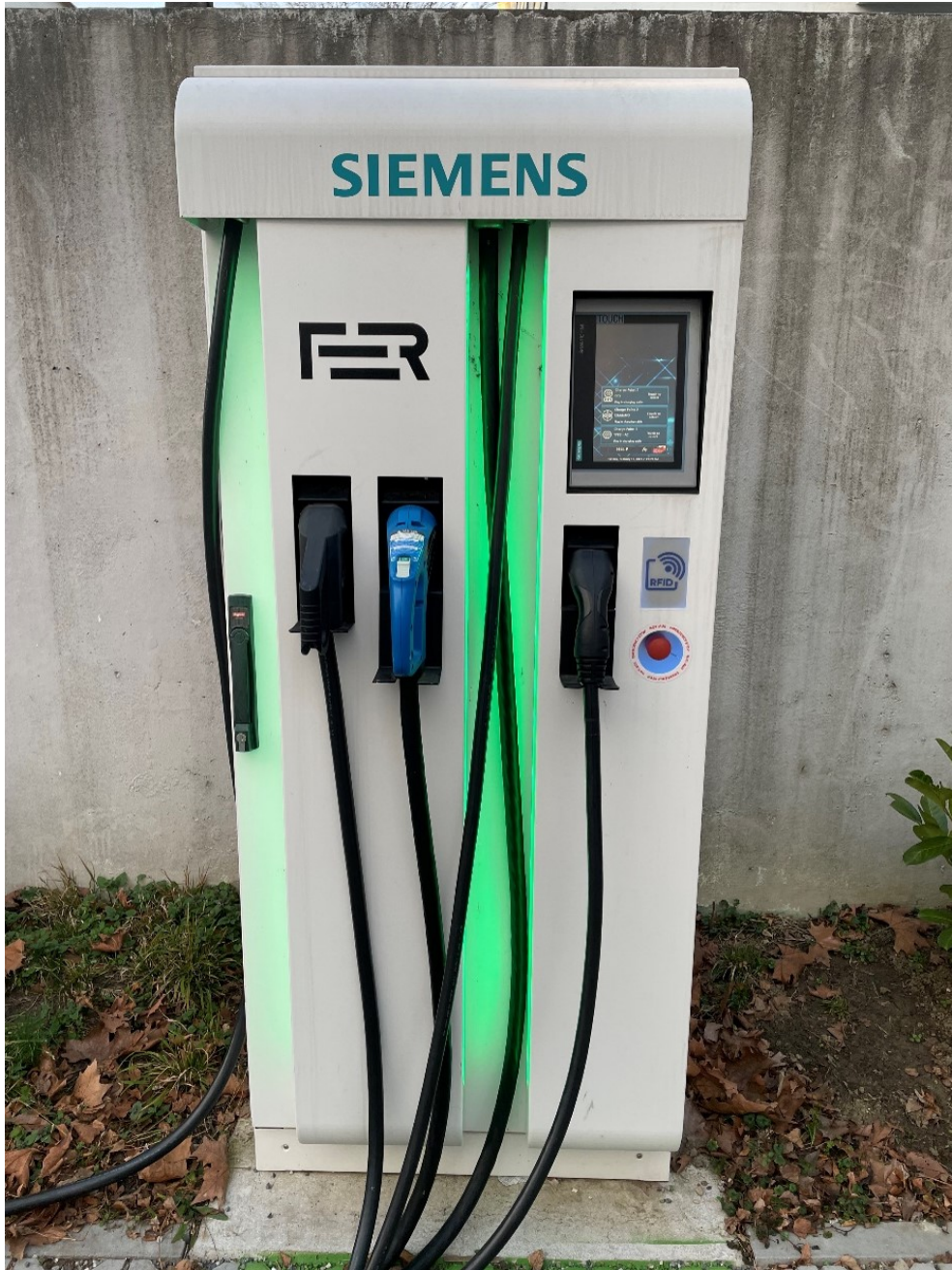
Slika 3.11: SGLab - brza punionica za električna vozila.
