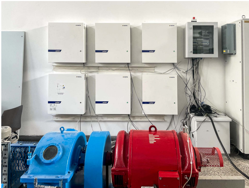
Slika 3.12: SGLab - baterijski spremnik.
