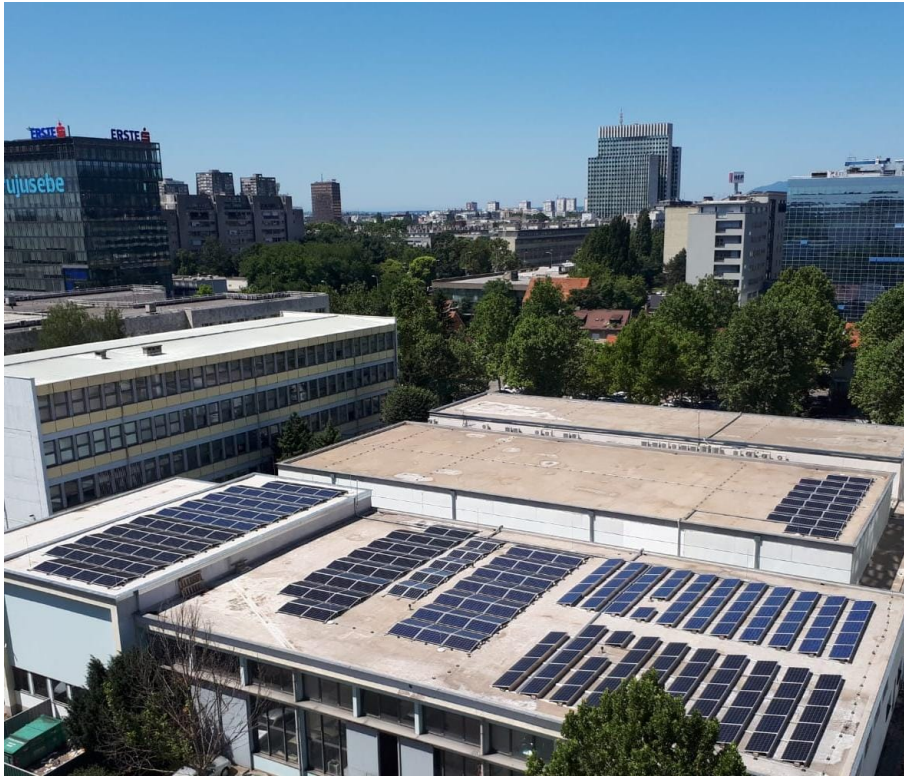
Slika 3.10: SGLab - fotonaponski paneli na krovu laboratorija.
