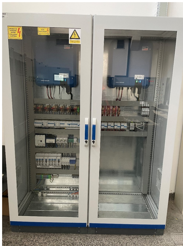
Slika 3.8: SGLab - ormar sa SMA inverterima fotonaponske elektrane.
