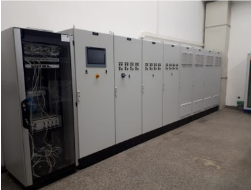
Slika 2.4: SGLab - ormari mikromreže.
