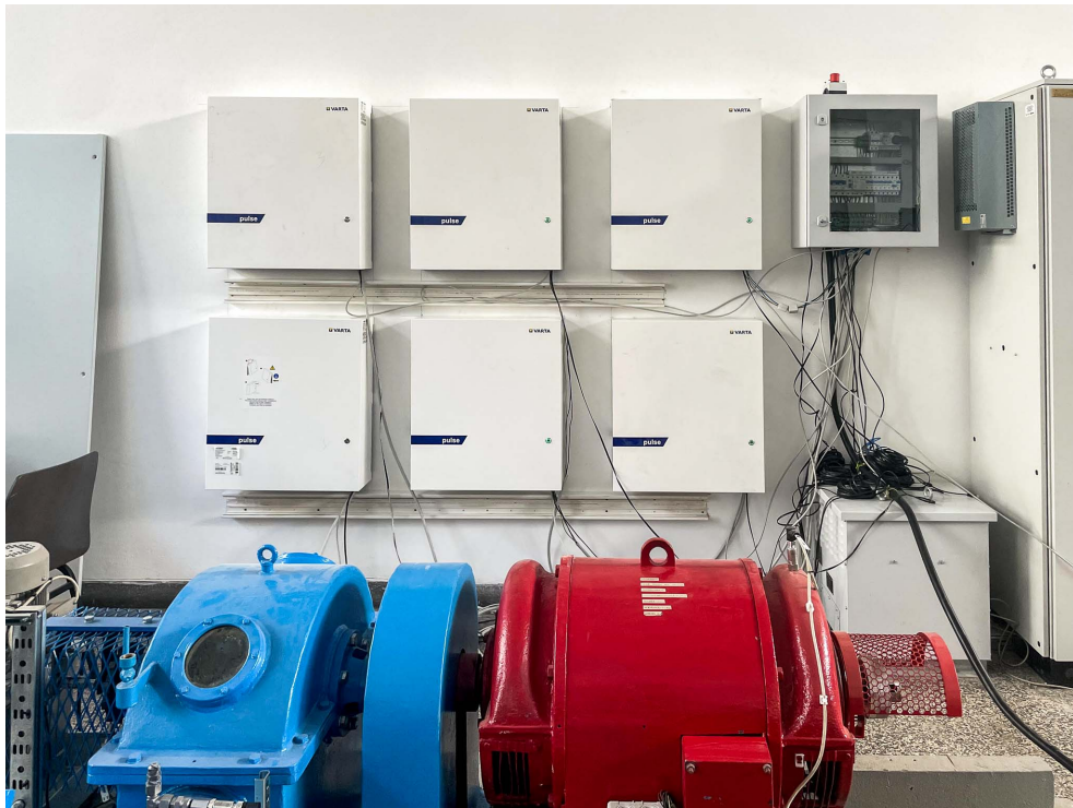
Slika 2.12: SGLab - baterijski spremnik.
