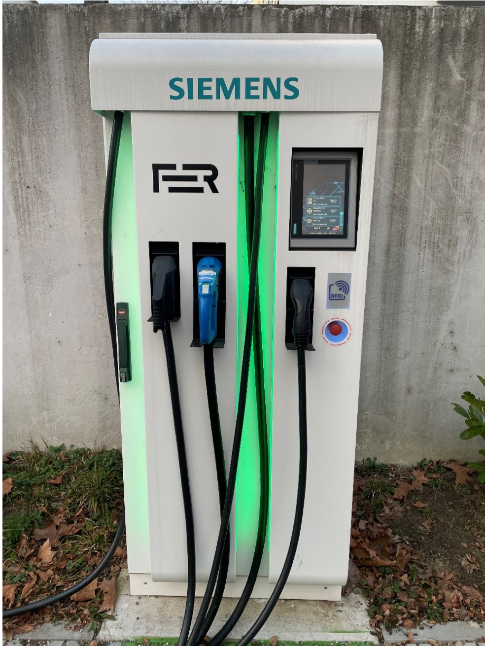
Slika 2.11: SGLab - brza punionica za električna vozila.
