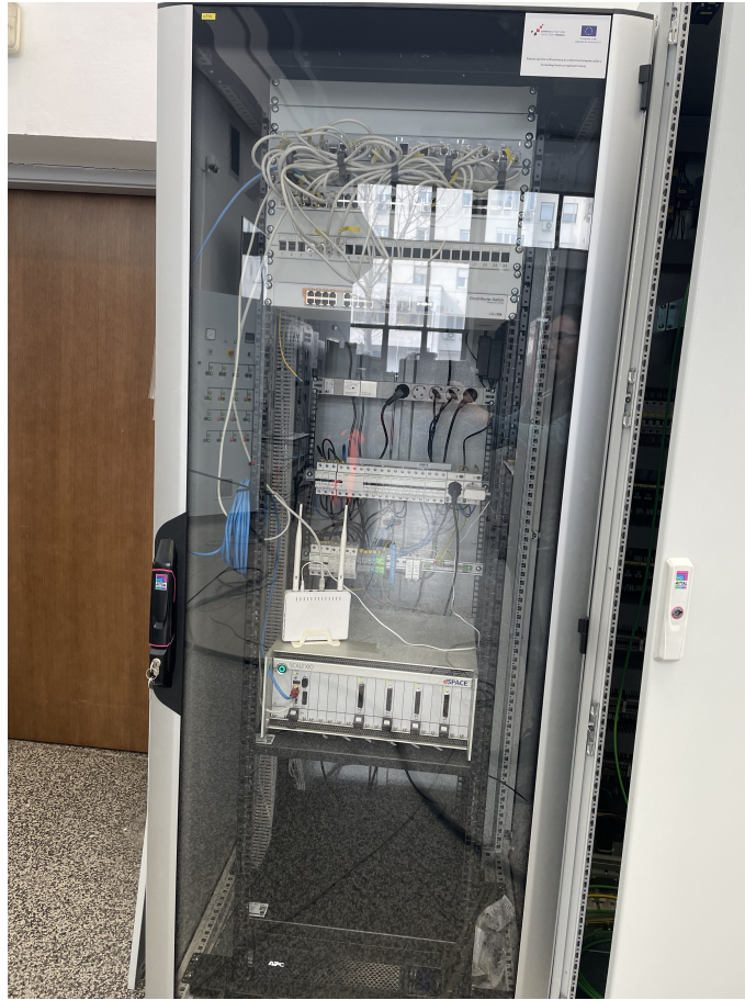
Slika 2.3: SGLab - komunikacijski ormar.
